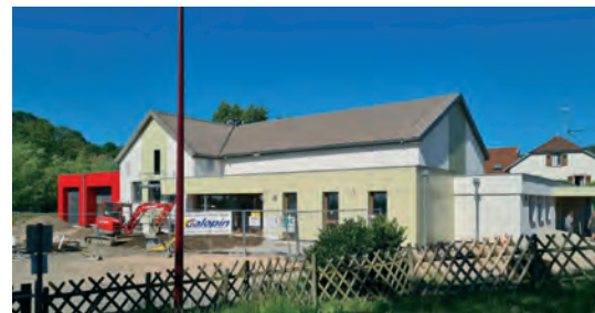
Salle polyvalente en cours de rénovation
