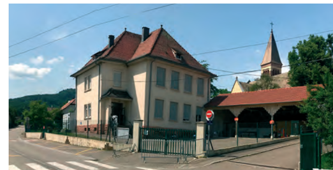
Ecole : façades avant avec cour et préau
