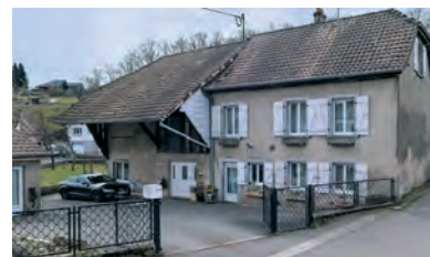
Exemple d'une ancienne grange accolée transformée en logement.
